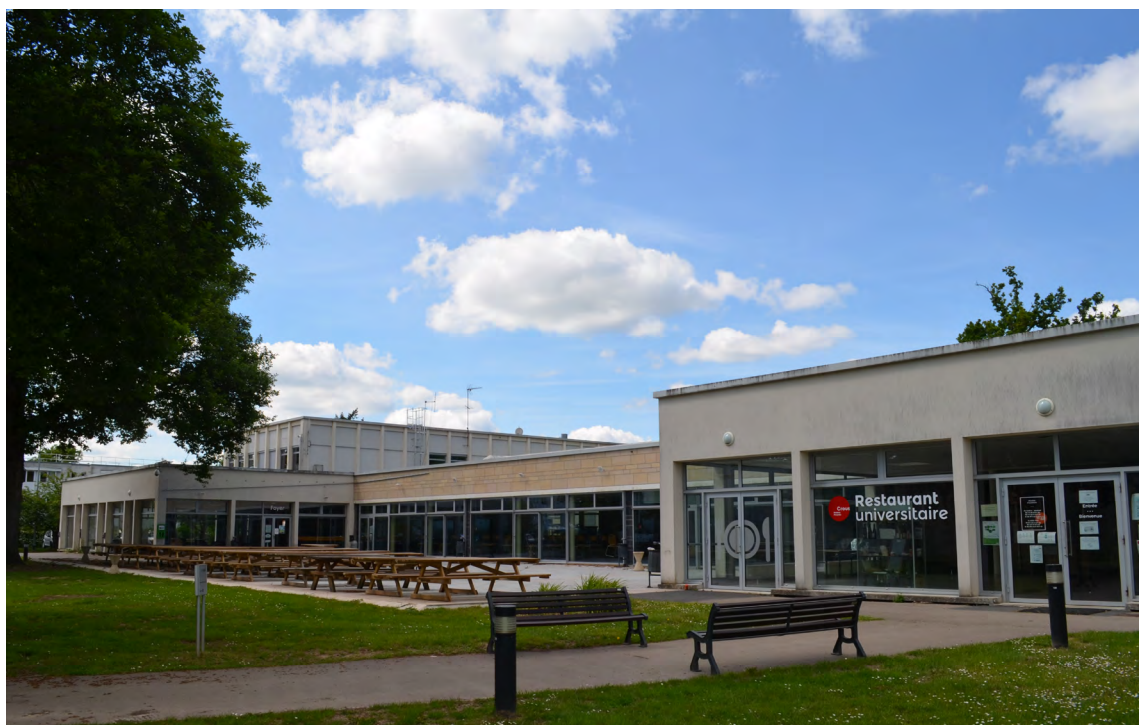
Photo : Façade du restaurant CROUS - Campus Beauvais
